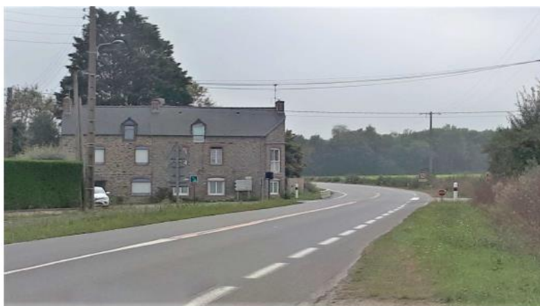
Un bâti proche, qui masque la visibilité au débouché de la voie communale, et un carrefour en sortie de courbe sont les principales sources de l'accidentologie
