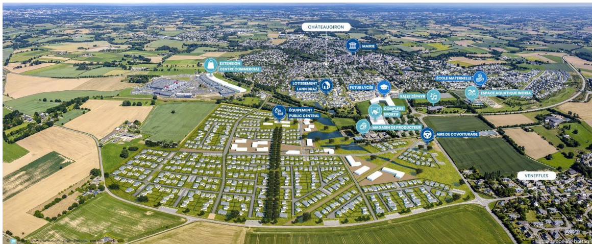
Figure 1 : intégration du projet dans la ville (dossier pièce 4, p. 80)
