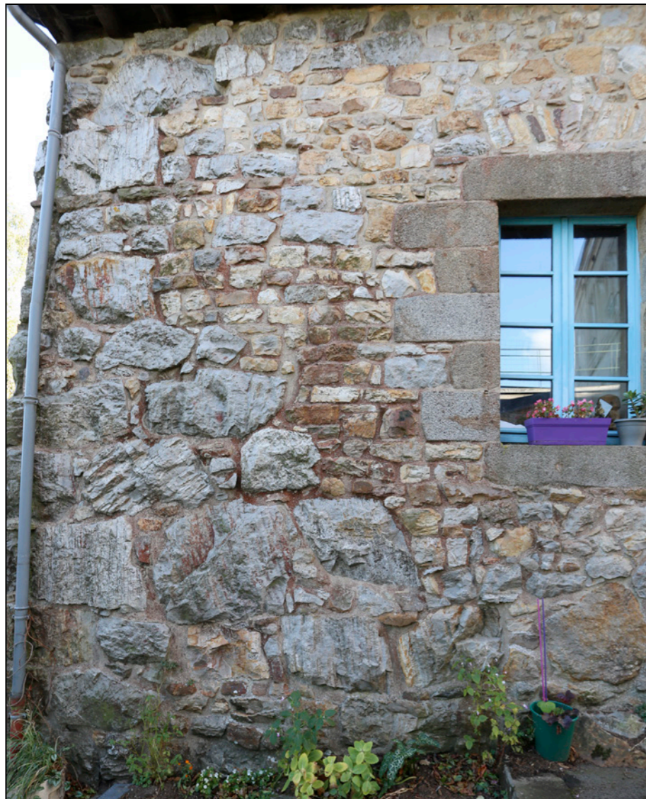
Fig.13 : Angle de maison construit en partie sur les anciens remparts de la ville, impasse de Grosse Roche (© P. Vendeville-2018)
