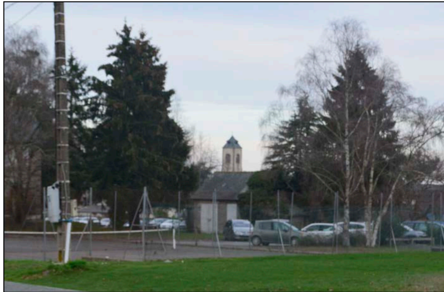
Fig.111 : Perception de la tour place Veillard depuis le bourg
