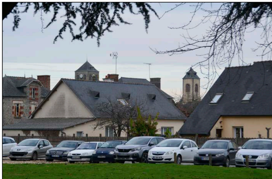
Fig.112 : Perception du clocher de l'église Saint-Aubin et de la tour place Veillard depuis le bourg
