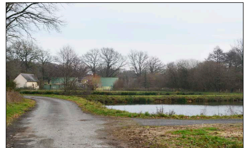
Fig.61 : Équipement communal dans le vallon de la Biennais et des Vallées - station d'épuration
