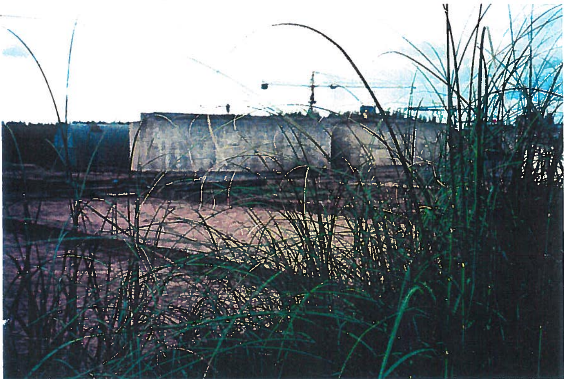
REDON : Station d'épuration sur la ZIP
