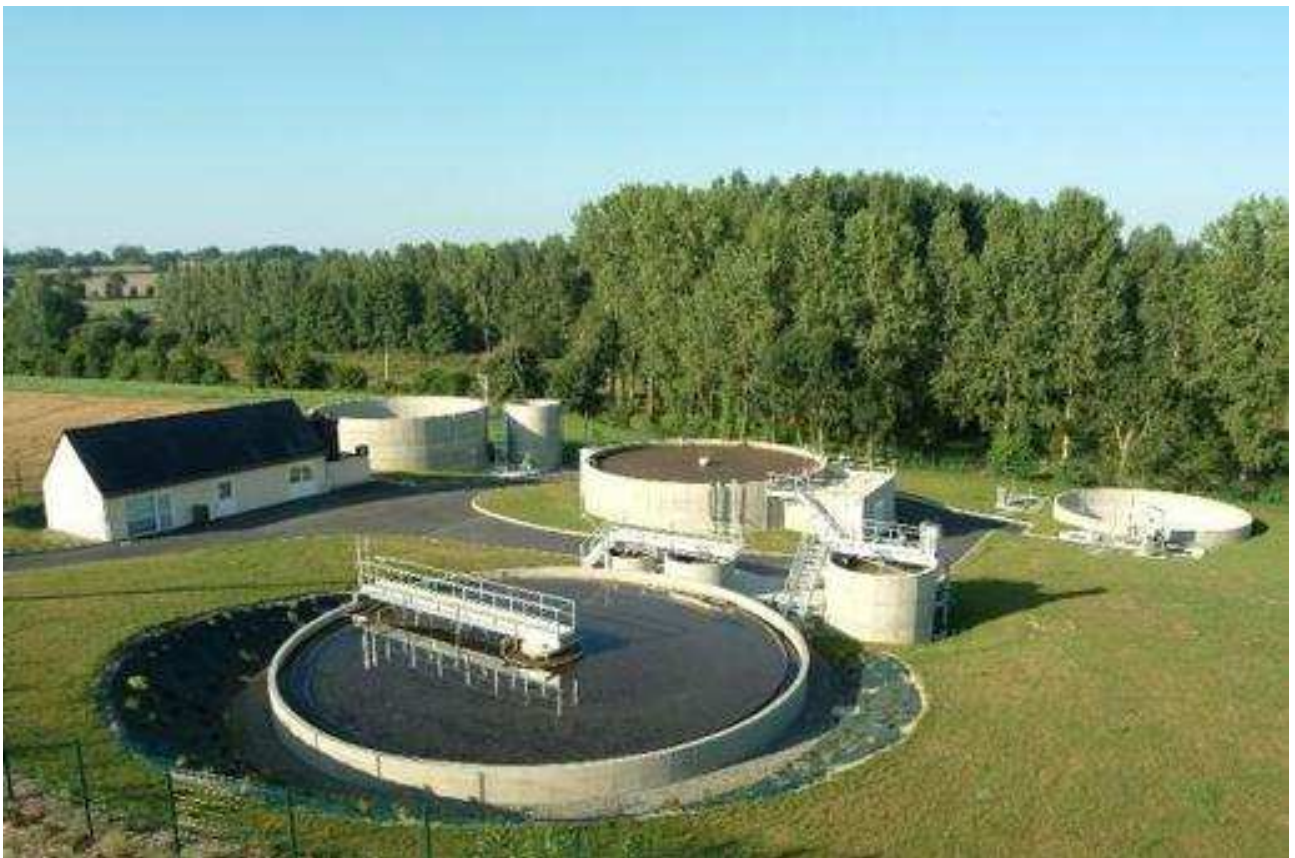
Figure 4 : Vue d'ensemble de la station d'épuration (2018)
