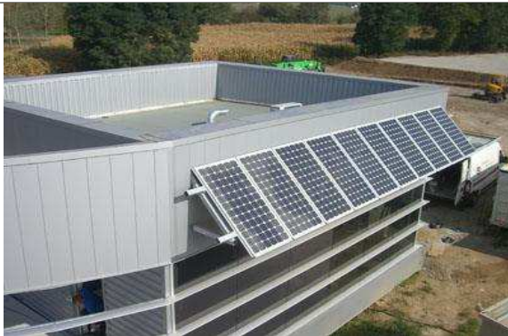
Exemple d'installation en brise-soleils photovoltaïques
