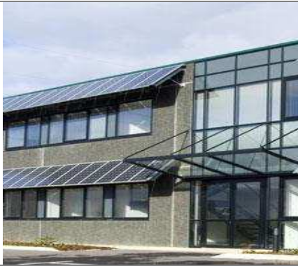
Exemple d'installation en brise-soleils photovoltaïques
