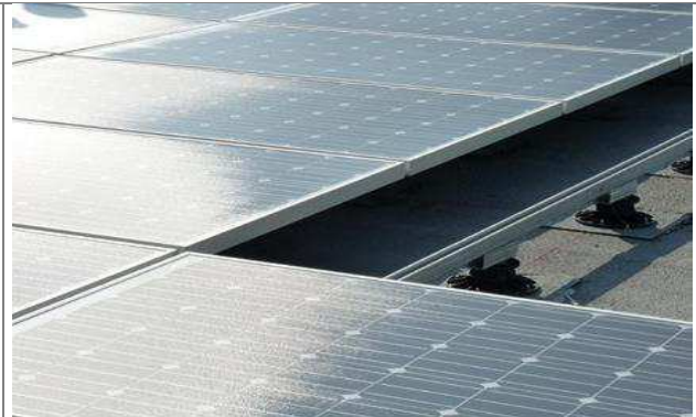
Modules sur plots (Solution Solardis)
