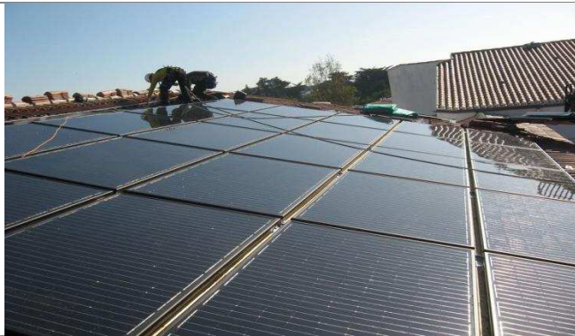
Intégration sur charpente bois
