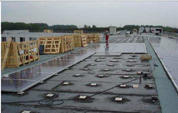
Mise en œuvre modules sur plots (solution SMAC)
