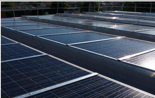
Système de toiture intégrant isolation et modules (solution Dani alu)
