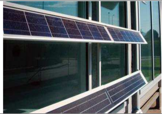
Exemple d'installation en brise-soleils photovoltaïques
