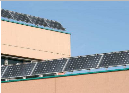
Installation avec garde-corps photovoltaïques
