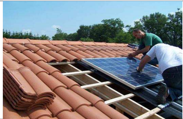
Mise en œuvre de modules
