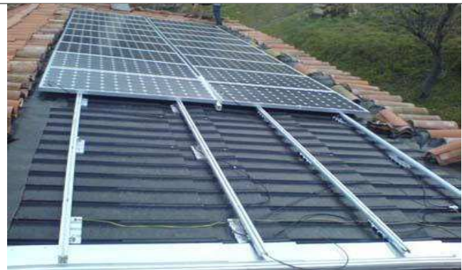
Mise en œuvre de modules
