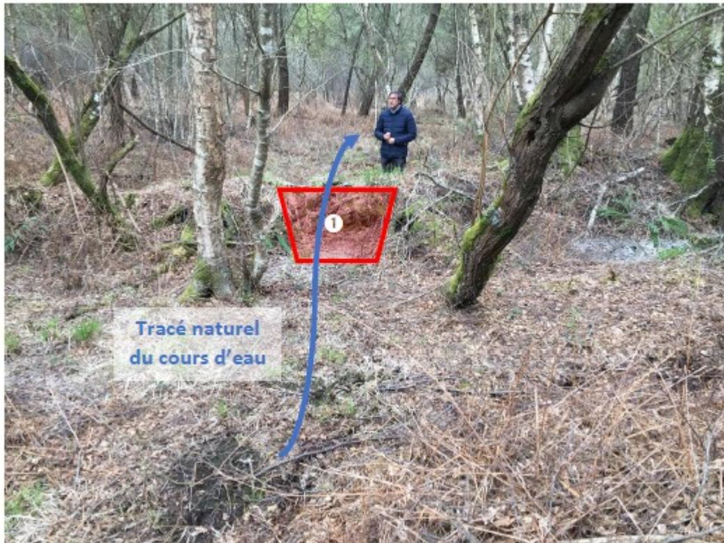
Point 2 : bouchon à mettre sur le fossé sur-créusé en amont du puits P1
