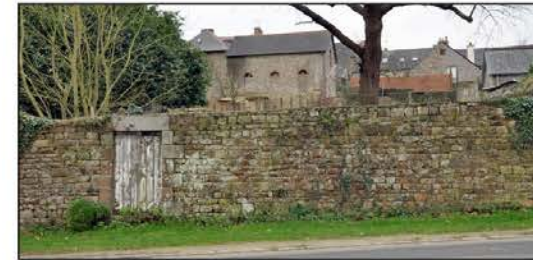
Fig.134 : Mur de clôture route de Fougères
