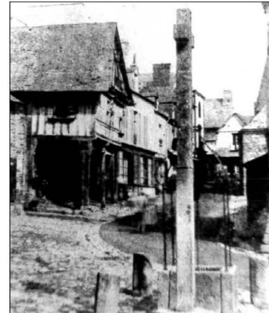
Fig.179 : Carte postale ancienne représentant les maisons à porche édifiées sur la rive ouest de la place du Carroir, Ire moitié du XIX e siècle (source : AD 35)
