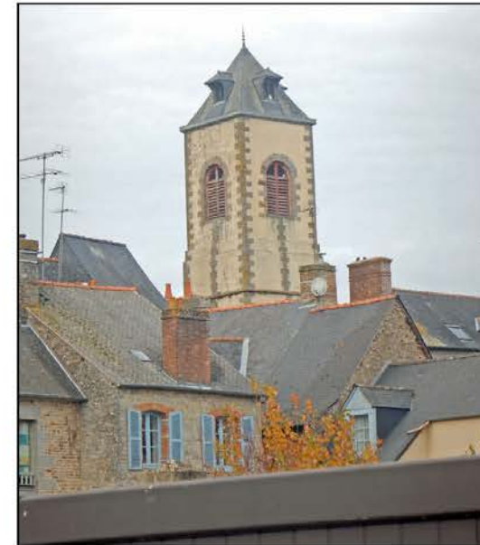
Fig.256 : Vue sur la tour Veillard
