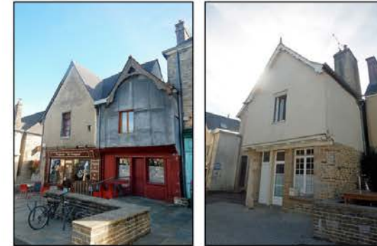
Fig.178 : Immeubles en pan de bois situés sur la place Alexandre Veillard formant à l'origine des maisons à porche. Le léger encorbellement témoigne de l'existence du portique qui a été comblé lors de réaménagement durant la seconde moitié du XIX e siècle.
