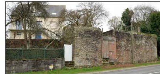
Fig.135 : Mur de soutènement route de Fougères
