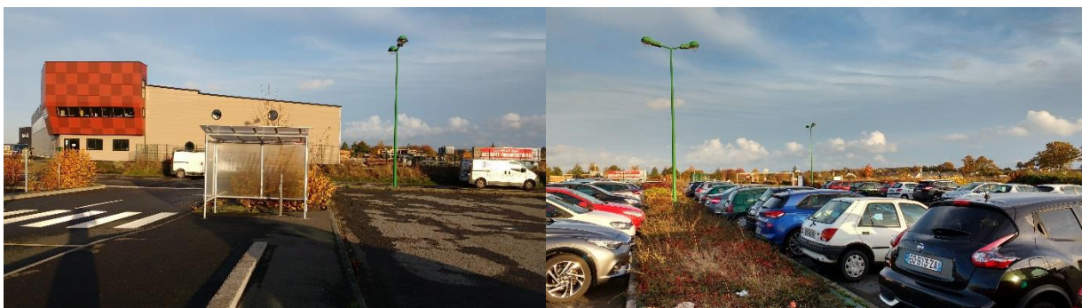
Exemple d'une aire structurante : aire de Romagné avec 140 places, revêtue, éclairée, arrêt de car et abri vélo
